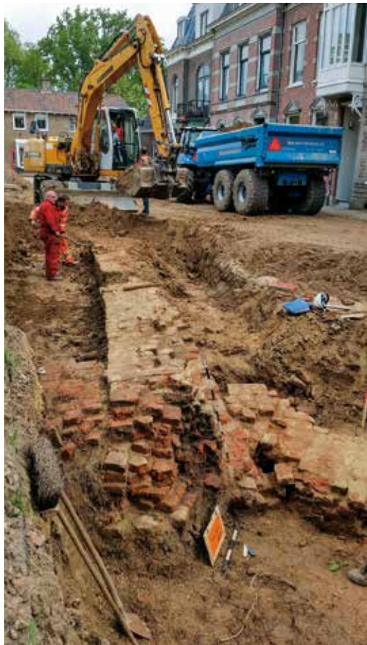
Fundamenten van de in 1673 opgeblazen kasteelmuren, Bowlespark mei 2015. Foto auteur.
