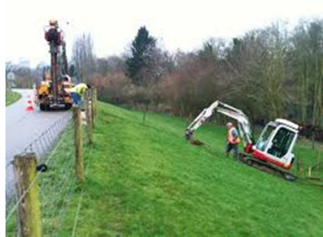
Onderhoud aan de Grebbedijk (foto Gelderlander)
