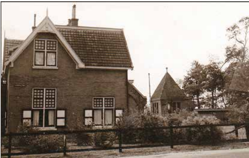
De dienstwoning van de machinist van het Gemeentelijk Waterbedrijf, met rechts het puntdak van het transformatorhuis en de lager gelegen werkplaats en machinekamers.
