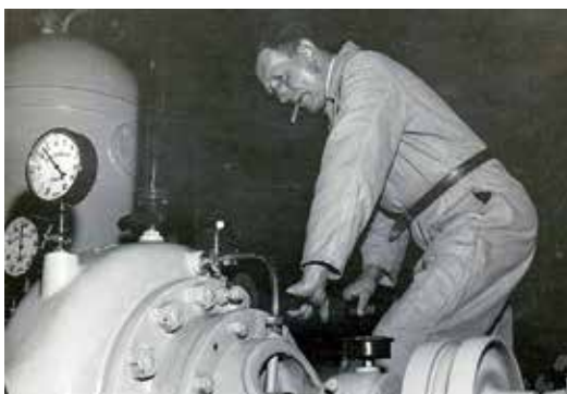
Jan Carel Bloemers aan het werk in de machinekamer van het pompstation, altijd met zijn lichte overall aan en een sigaar in zijn mond.
